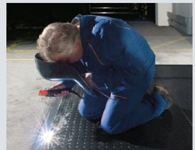
Soldar al premarco rebajado y listo.
