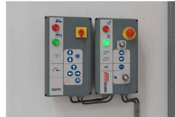
La luz indicadora del panel de control COMBILOK<sup>®</sup> G<sup>2</sup> se vuelve verde y señala que el vehículo está retenido de manera segura por el G<sup>2</sup>. La luz indicadora del panel de control la rampa también se vuelve verde, lo que indica que la rampa está en posición y que la carga o descarga puede comenzar de manera segura.
