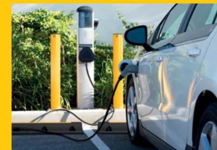
Bolardos que protegen puntos de carga para coches eléctricos.
